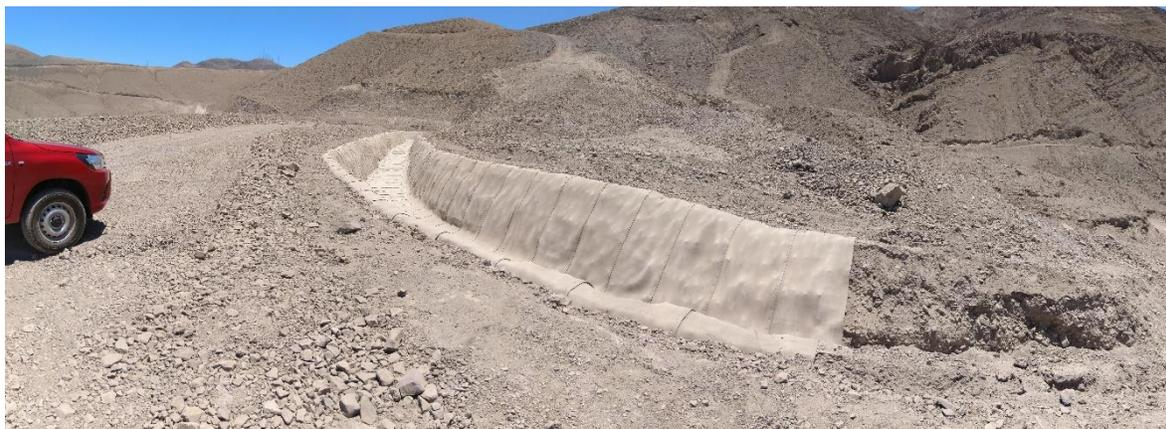
Imagen N° [ ] correspondiente al codo que permite canalizar las aguas hasta el sector rápido de descarga.
