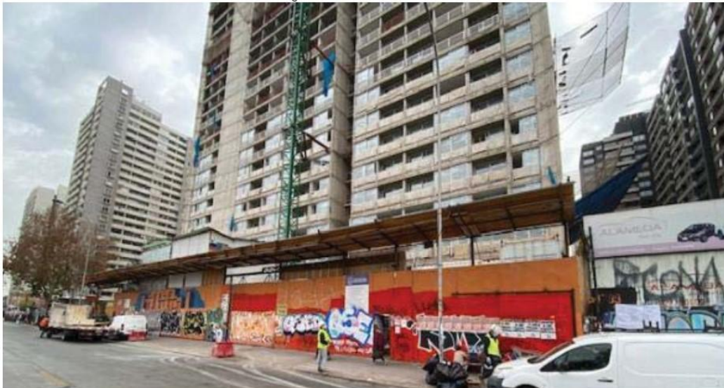
Fotografía 4. Barrera deslinde sur
