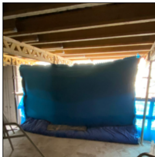
Barreras móviles en obra
