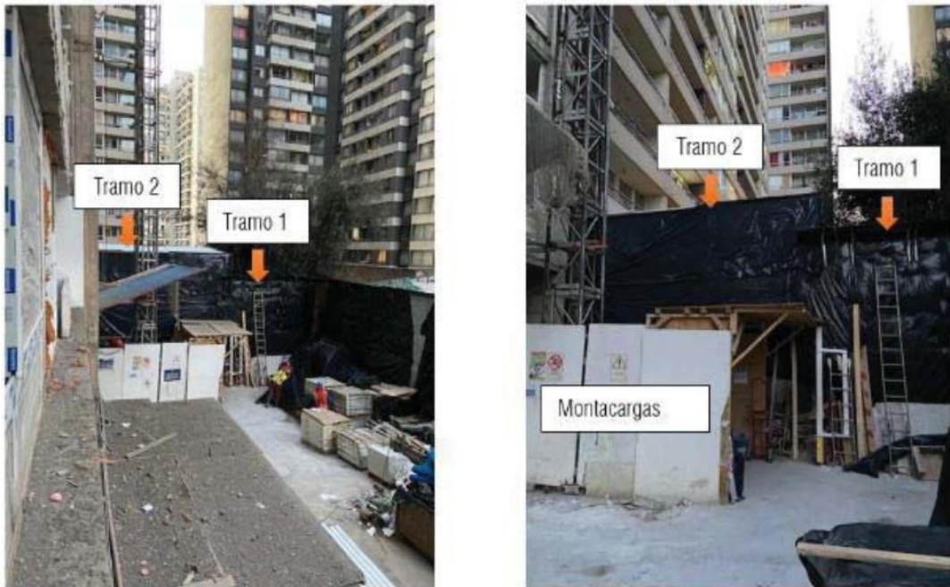
Fotografía 3. Detalle barrera norte
