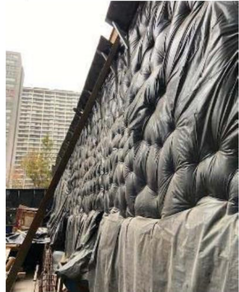
Fotografía 9. Detalle de cierres perimetrales empleados en obra
