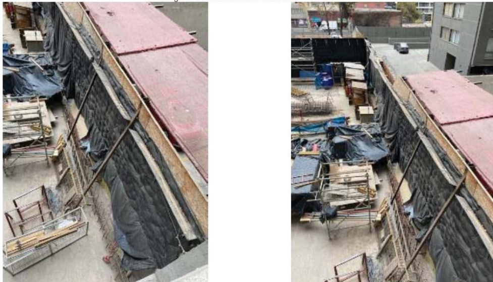
Fotografía 2. Detalle de cierres en deslinde norte
