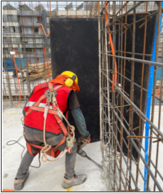
Biombo acústico (Avance de Obra Gruesa)
