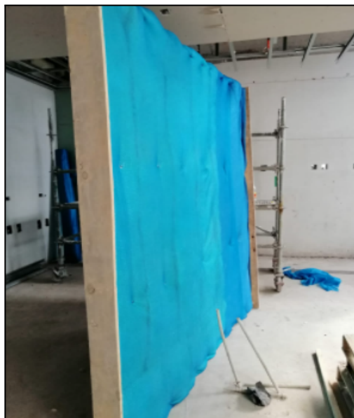
Pantalla de aislamiento acústica empleada en bomba de hormigón
