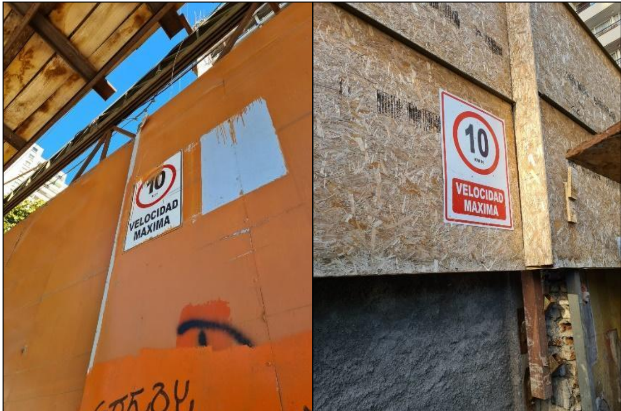
Señalética velocidad máxima instalada en acceso a obra
