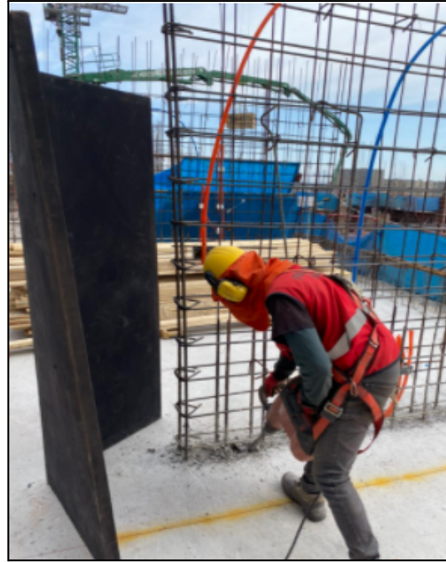
Biombo acústico (Avance de Obra Gruesa)
