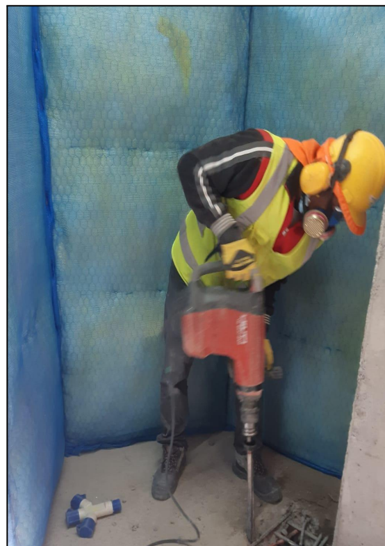
(Bombo acústico utilizado en terminaciones)
