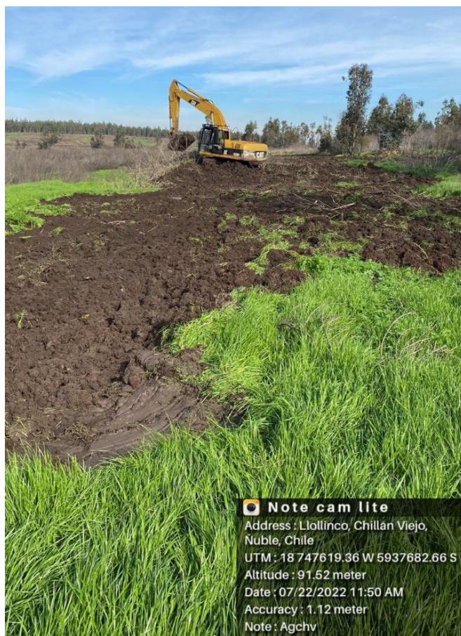
Figura 28: Trabajos de limpieza con maquinaria
