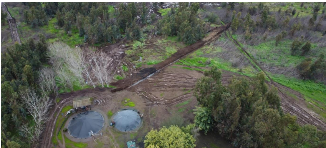
Figura 30: Pretil de contención
