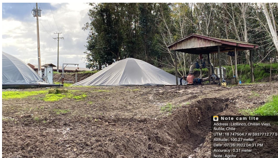
Figura 31: Pretil de contención
