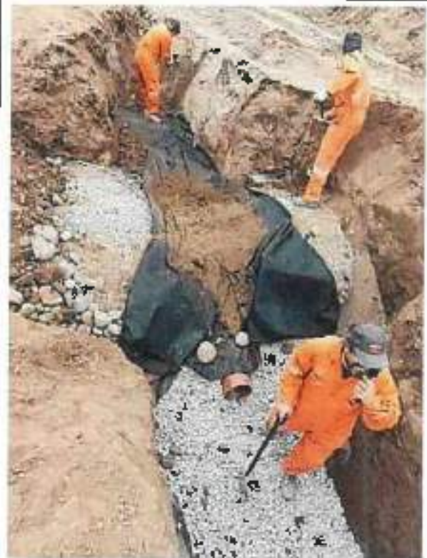
Fotografía 7. Cerrado de geotextil y tapado de drenes cerrados.
