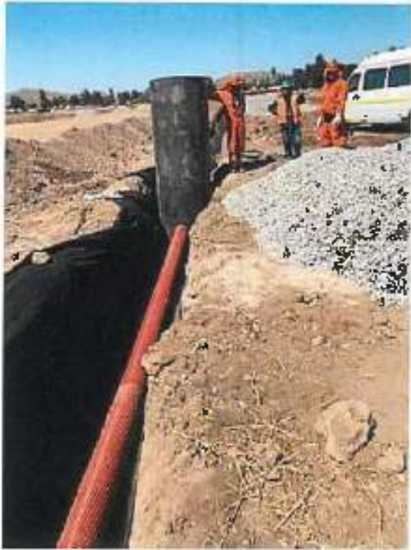
Fotografía 6. Instalación de cámaras de inspección en drenes enterrados.
