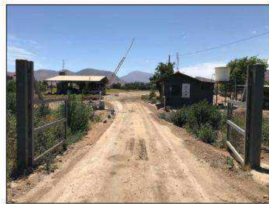
Acceso (porteria) Mina Júpiter
