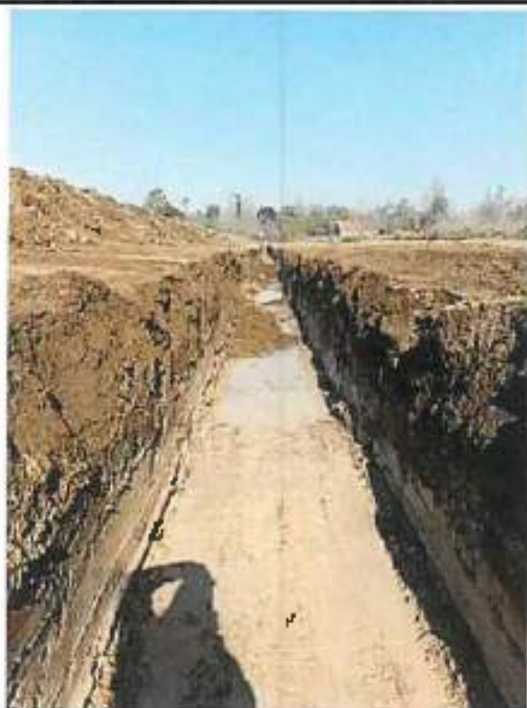
Fotografía 4. Excavación de drenes enterrados.
