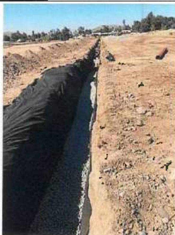
Fotografía 5. Instalación de geotextil, grava y tubería en drenes enterrados.
