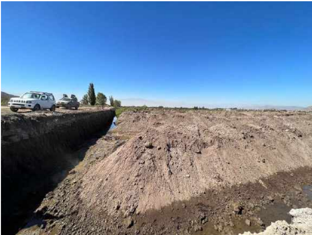
Fotografía 3. Corte abrupto del suelo producto de la extracción de arena.
