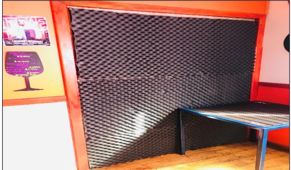
Aplicación Material Fonoabsorbente
