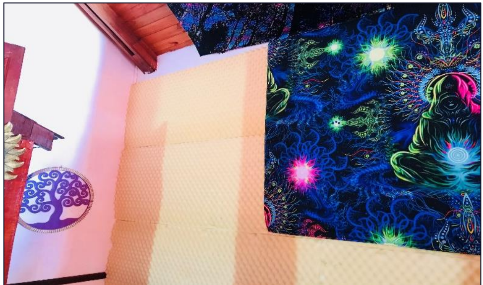
Aplicación Material Fonoabsorbente
