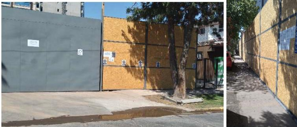
Figura 15: Cierre perimetral sector poniente (febrero 2021)
