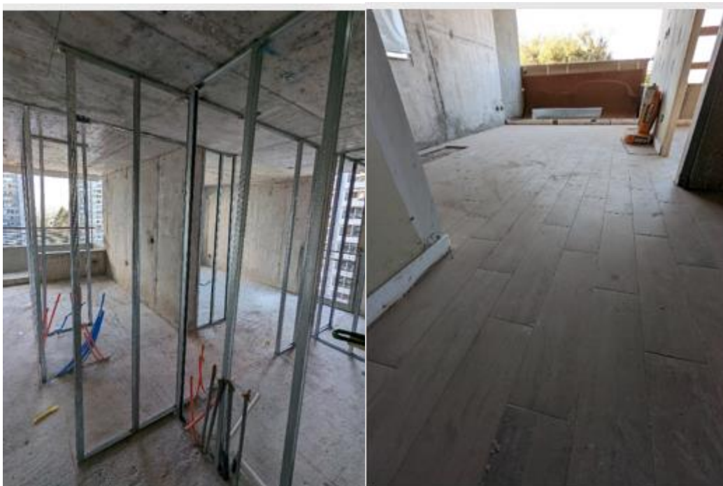
Figura 2: Estructura tabiques (piso 11) e instalación revestimientos cerámicos (piso 5)
