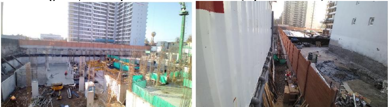
Figura 17: Cierre perimetral sector oriente (septiembre 2021)
