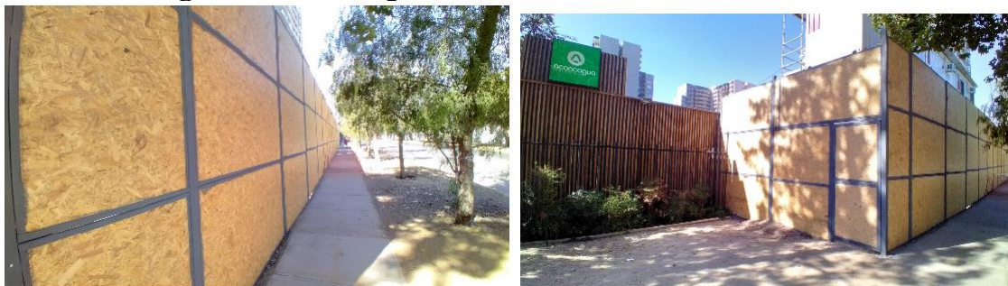
Figura 16: Cierre perimetral sector sur (abril 2021)
