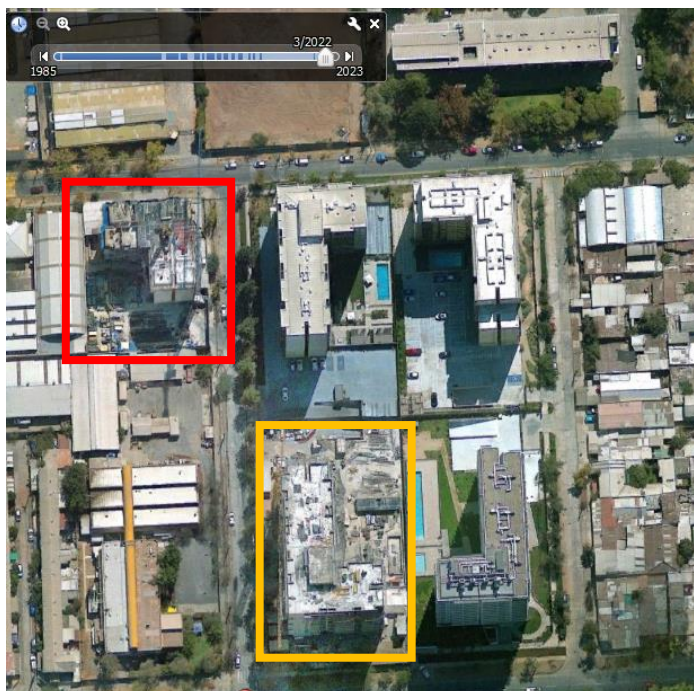
Figura 25: Ubicación de la obra denunciada (rojo) y Edificio Neus 2 (amarillo) en marzo de 2022
