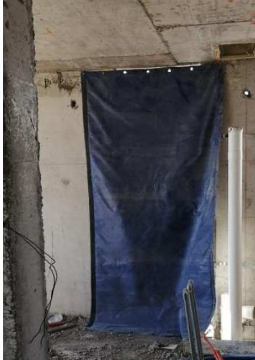
Figura 18: Cierre de vano con barrera acústica flexible
