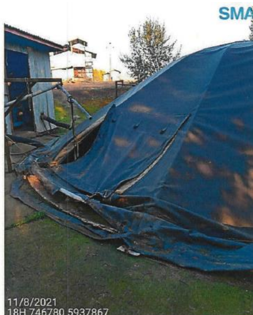
Foto N° 1. Estación N° 1 pozo de acumulación recría, fotografía muestra que la unidad no está completamente sellada.
