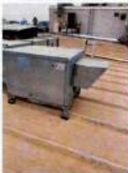
Vex habitaciones Main Del piso 2 al piso 6 (4 unidades) Azotea edificio Main
