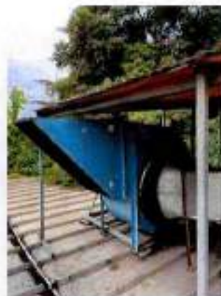
Vex Pastelería marquesina Marquesina patio de descarga
