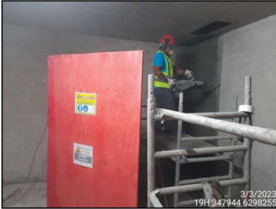
Trabajos con rotomartillo
