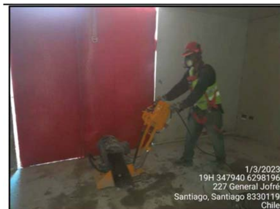
Pulidora de pisos con apantallamiento acústico implementado
