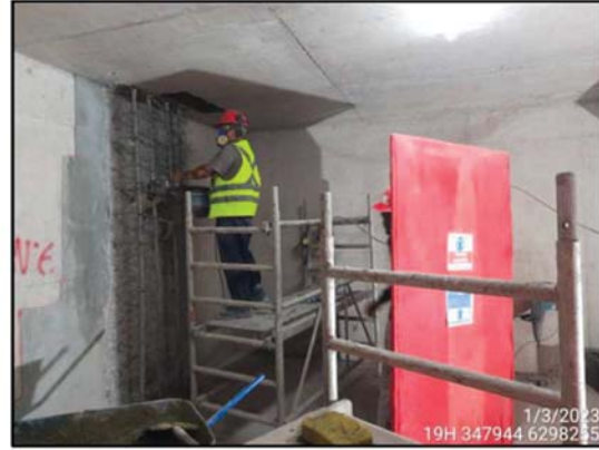
Trabajos con Rotomartillo y apantallamiento acústico implementado
