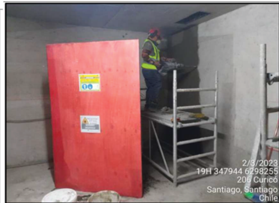
Trabajos con Rotomartillo y apantallamiento acústico implementado
