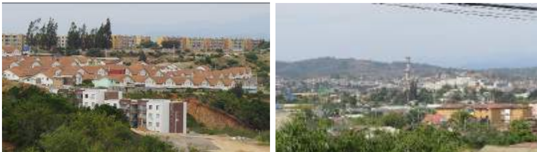
Fotografía 26: Impermeabilización de Suelos por Urbanización
