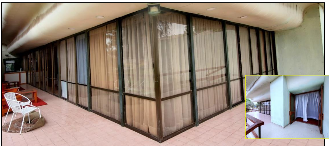
Figura 4: Detalle de flanco frontal e izquierdo del Salón Tarapacá. Se aprecian particiones en forma de ventanales en todo el perímetro, una terraza y barreras acústicas modulares/móviles.
