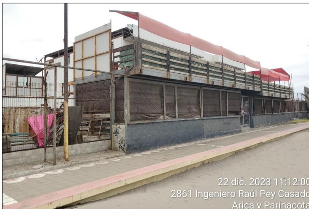
**Figura 3:** Vista de flanco norte primer piso: Se aprecia ausencia de particiones que contengan el disturbio.
