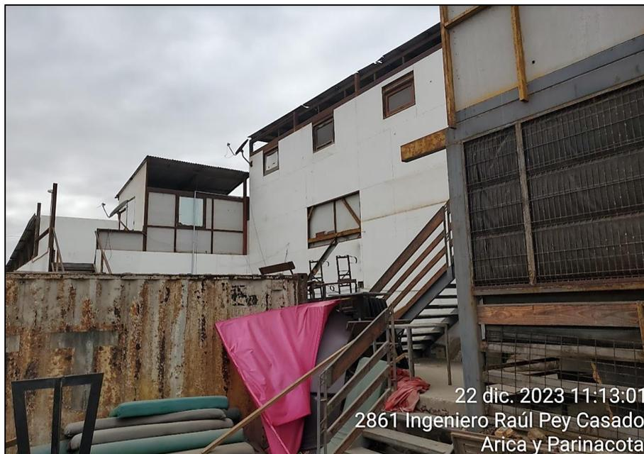
**Figura 4:** Vista de flanco norte segundo piso: Estructura metálica con planchas de fibrocemento.
