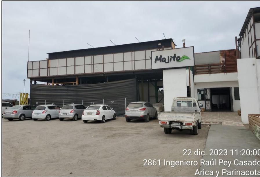
**Figura 6:** Vista de flanco este: Fachada con muro de hormigón, reja metálica y fibrocemento.
