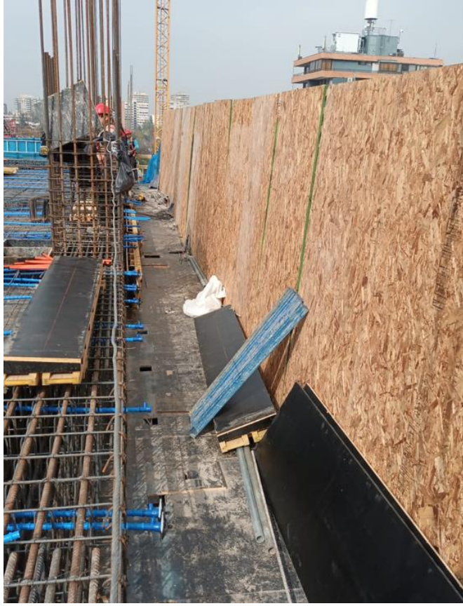
Barreras modulares en Losa de Avance
