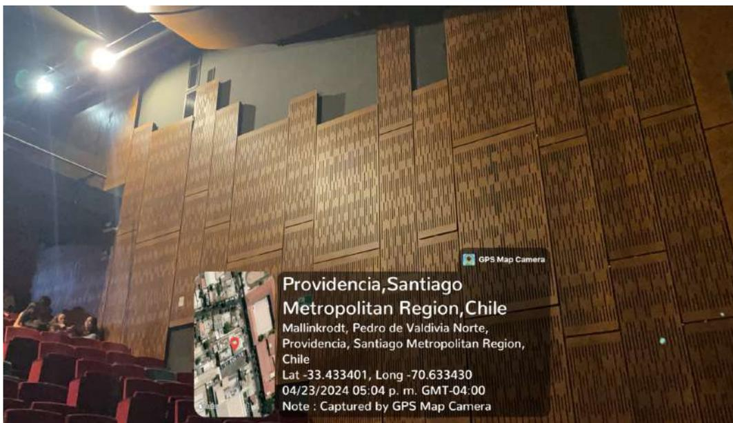
Sala totalmente revestida y sellada con madera con perforaciones especiales para absorber sonido de marca Hunter Douglas.
