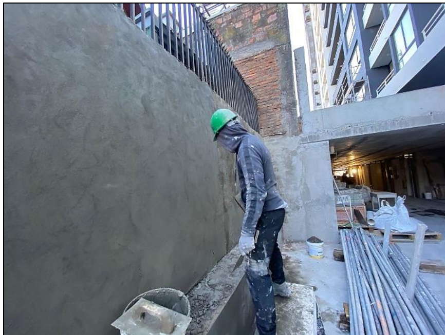
Figura N°2. Imagen de las Obras
