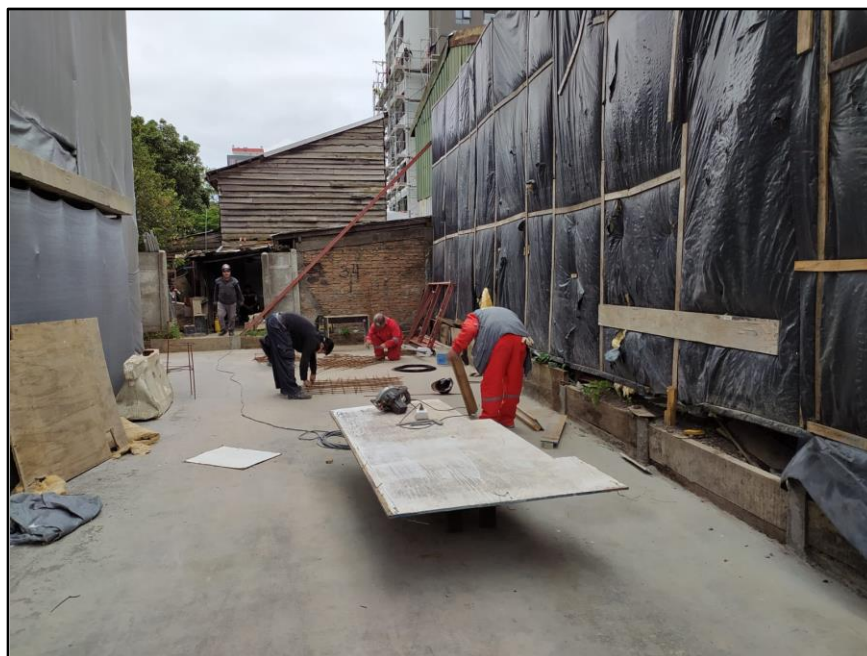
Figura N°2. Imagen de las Obras
