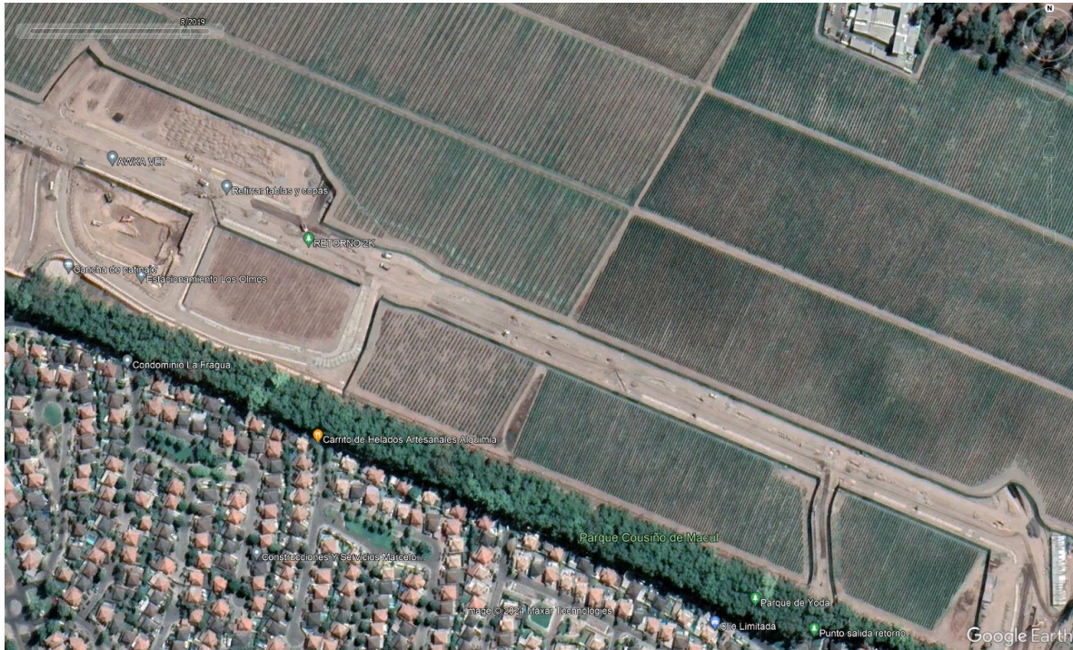
Figura 2. Avance de Obra a Agosto 2019. Fuente: Google Earth.
