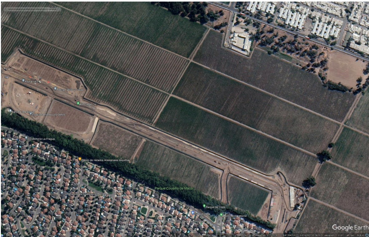
Figura 5. Imagen Satelital: Avance de Obra a Febrero 2019. Fuente: Google Earth
