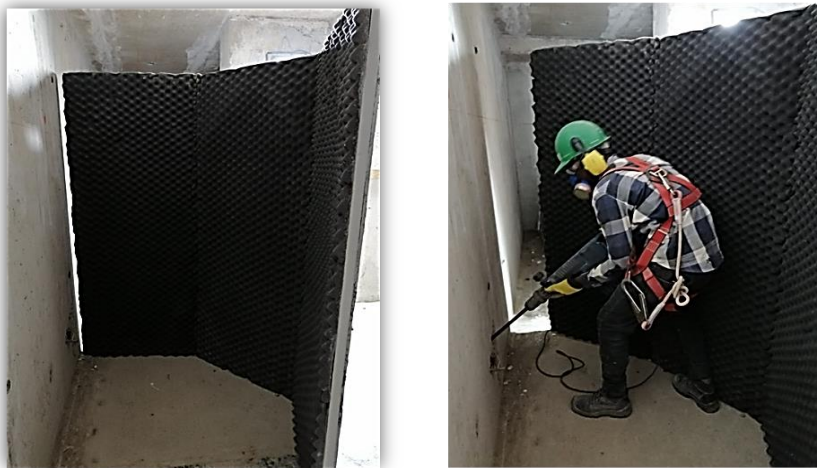
Imagen 3: Pantalla acústica móvil, para el Martillo demoledor y sierra. Recomendación ETFa
