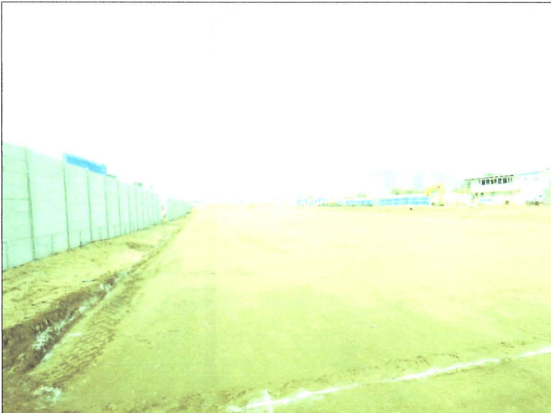
Ilustración 1. Vista general del interior del proyecto (obras preliminares)
