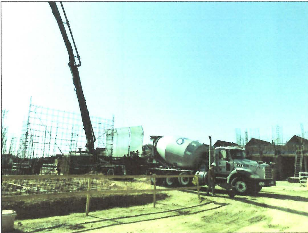
Ilustración 2. Vista general del interior de la obra
