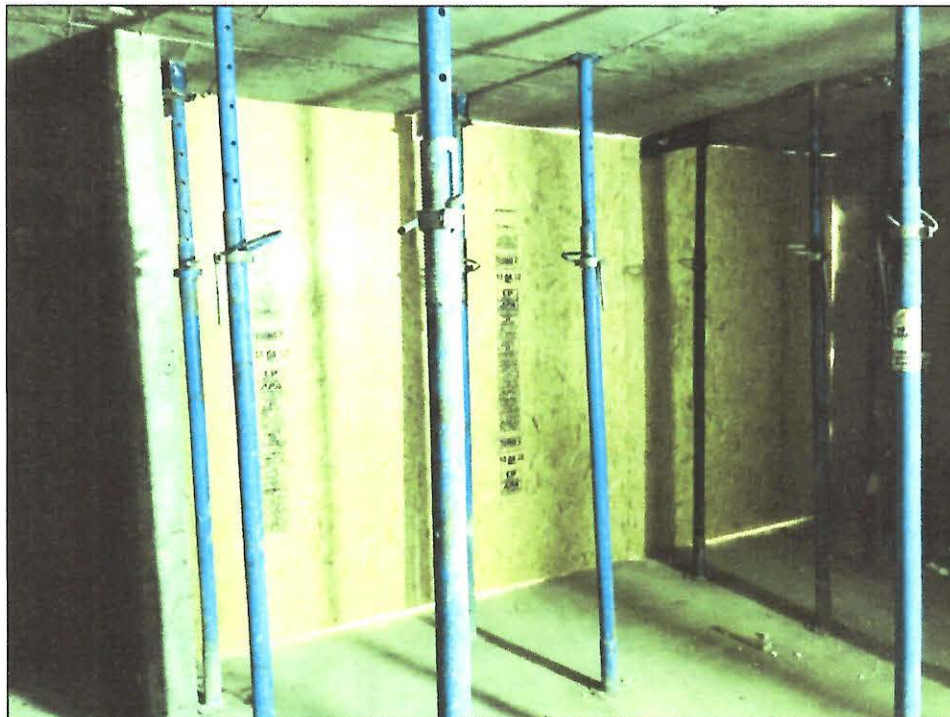
Ilustración 6. Fotografía del cierre de vanos desde el interior de una de las torres
