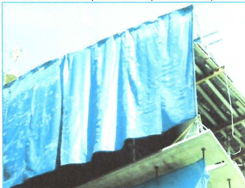
Ilustración 12. Ubicación y extensión de la pantalla acústica perimetral
