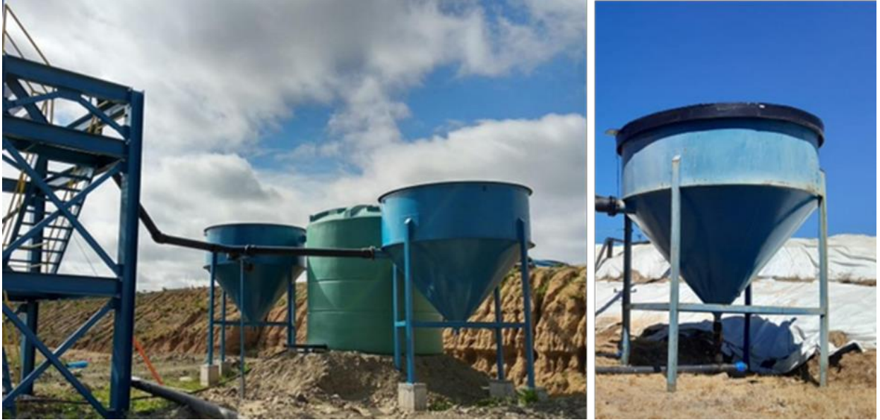
A la izquierda pueden verse los sedimentadores sin la cubierta, y a la derecha con dicha cubierta ya instalada.
