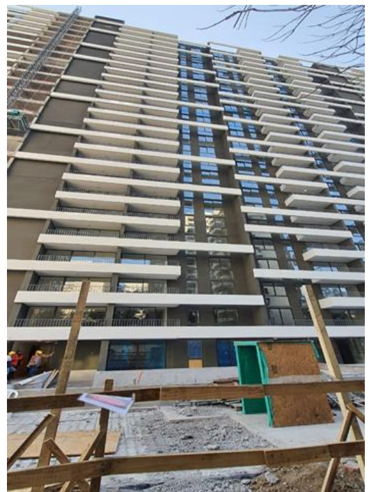
Instalación de ventanas definitiva
