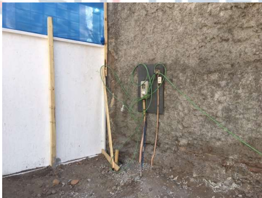
Imagen 22.- Medidor Electrico
