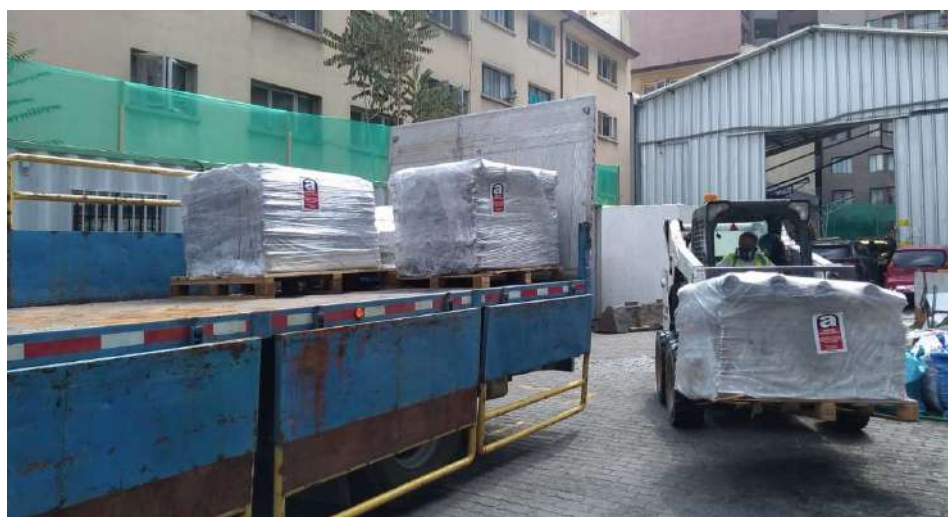
Imagen 5.- Retiro planchas onduladas MCA con disposición final a plantade tratamiento.
