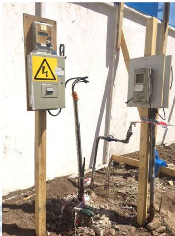
Imagen 22.- Medidores Electricos y de agua
