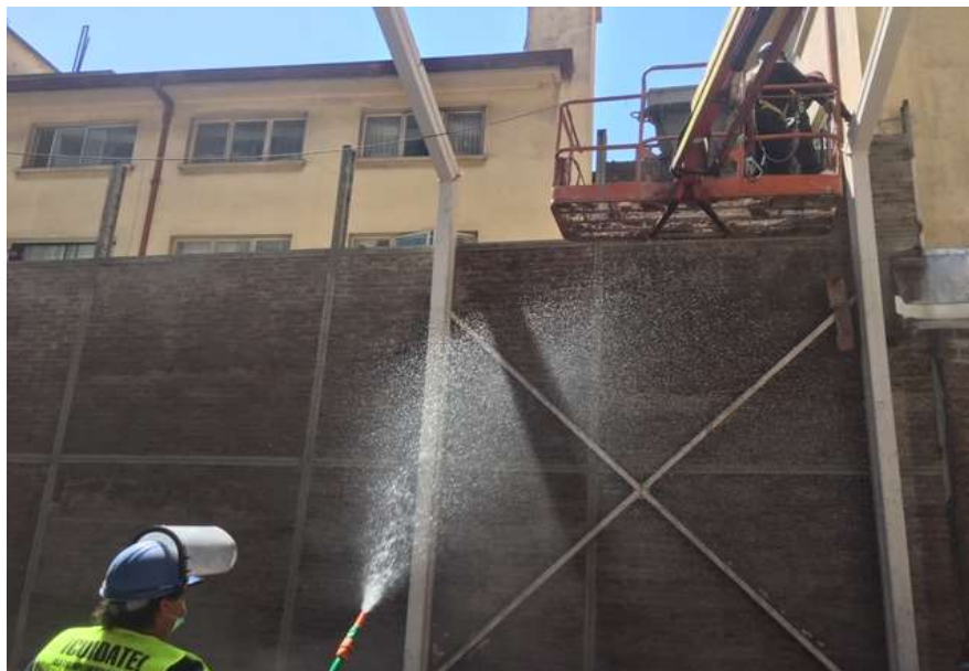
Imagen 11.- Rebaje tramo muro divisorio Norte
