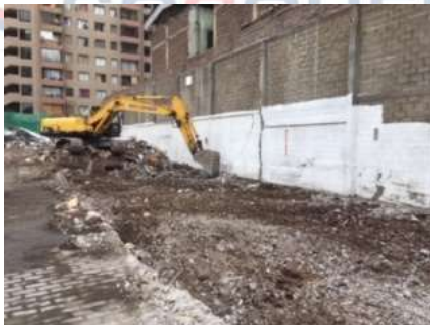
Imagen 7.- Demolición mecánica.
