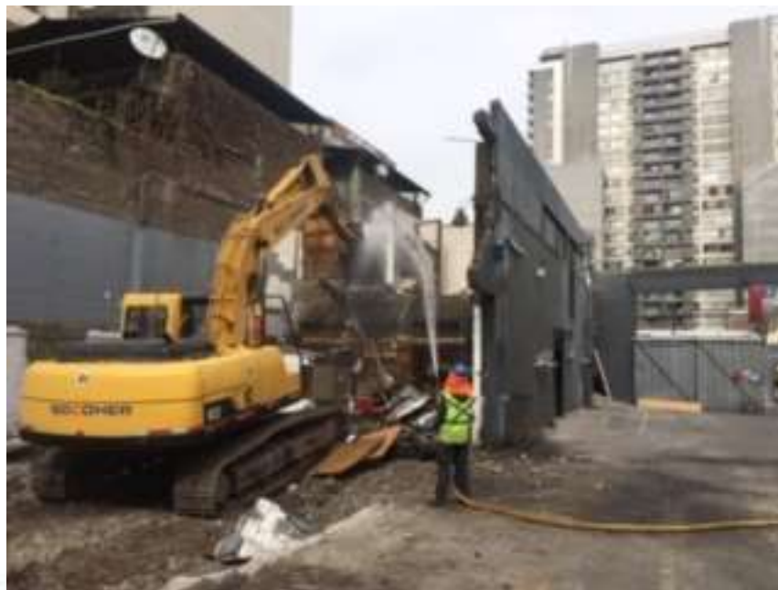
Imagen 8.- Demolición y riego constante alto caudal.
