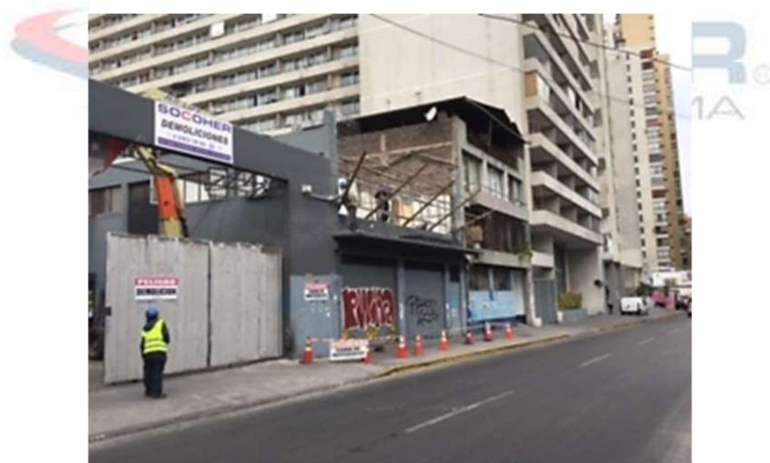
Imagen 11.- Desarme abanico protección
