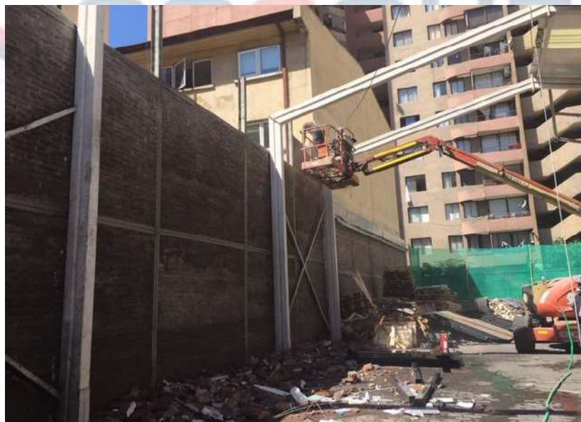
Imagen 10.- Retiro cubiertas ala Norte galpón 2
