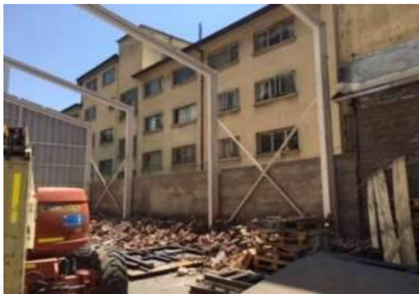
Imagen 4.- Desarme Galpon 2 y rebaje muro Norte
