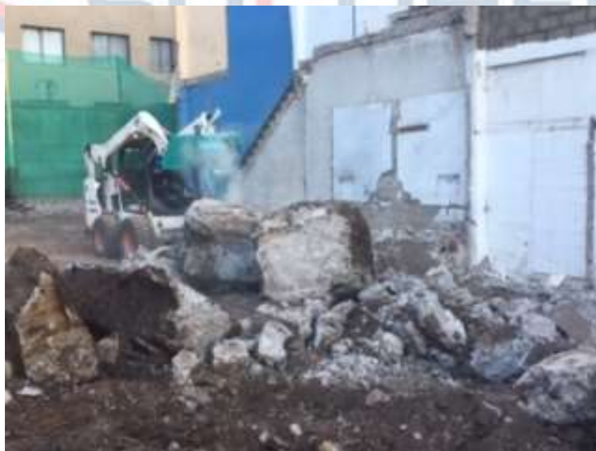
Imagen 15.- Demolición de fundaciones
