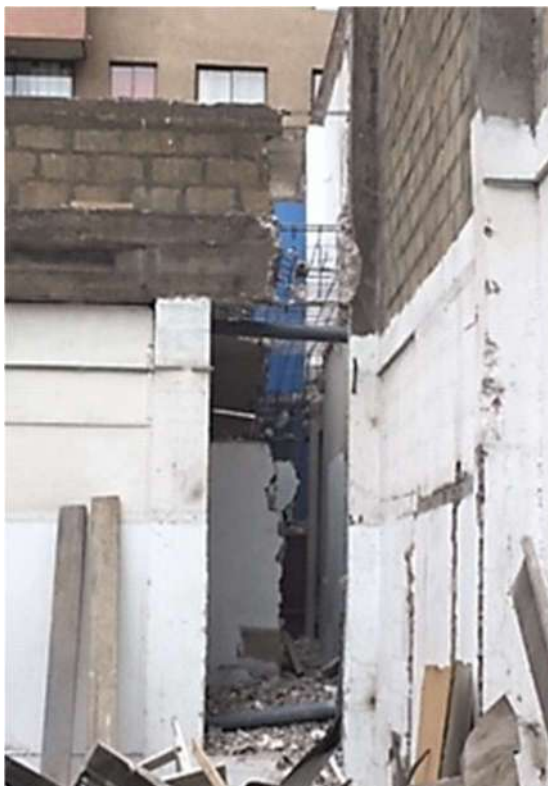
Imagen 6-7.- cortes de dilatación a muro medianero Norte
