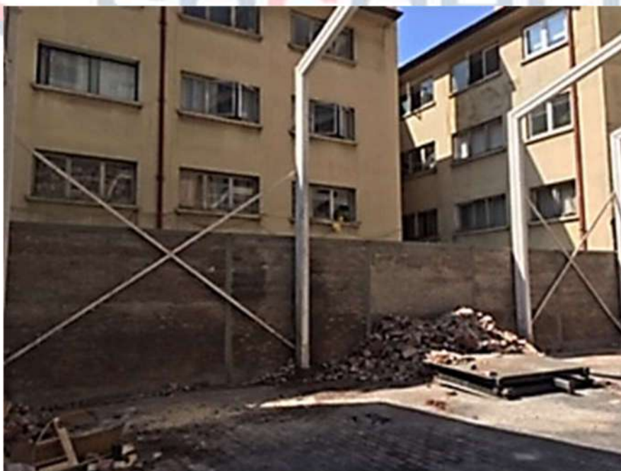
Imagen 12.- Tramo rebajado muro divisorio Norte
