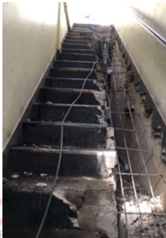
Imagen 6-7.- cortes de dilatación a muro medianero Norte
