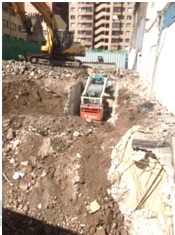
Imagen 16.- Demolición de subterráneo
