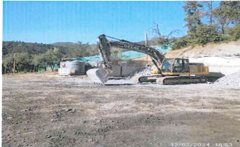
Figura 9: Uso de excavadora en reemplazo de cargador frontal
