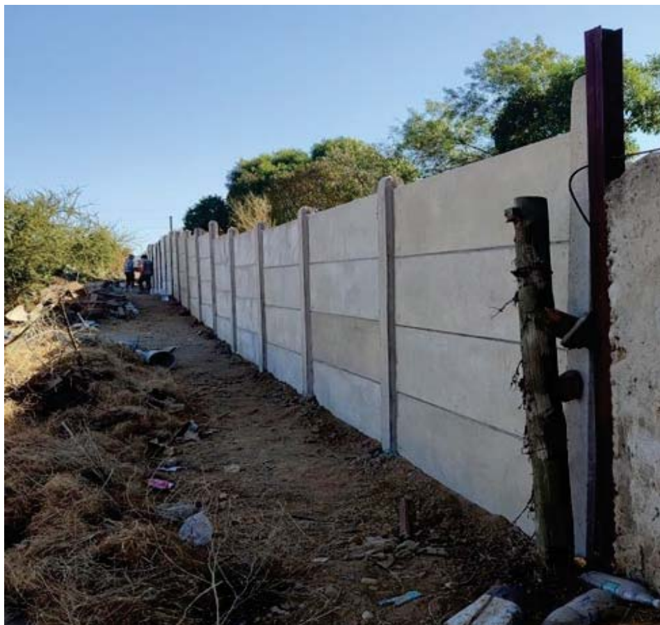
Figura N° 13. Nuevo cierre perimetral del sector oriente
