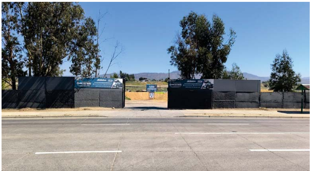
Instalación de barrera acústica en el portón de acceso principal del CADQ
