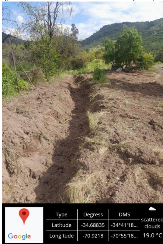
Imagen 8. Mantenimiento de la Canaleta Interceptora (actual)
