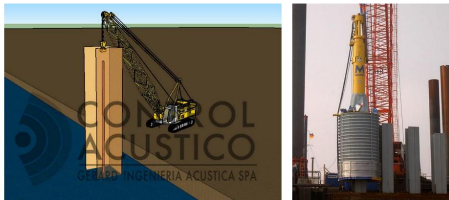
Figura 1: Medidas de control de ruidos en hincado de pilotes. Anexo 21 Adenda N°1 RCA N°71/2020
