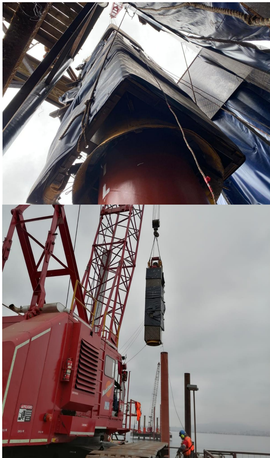
Figura 8: Fotografías de martinete con protección adicional. Septiembre 2022.
