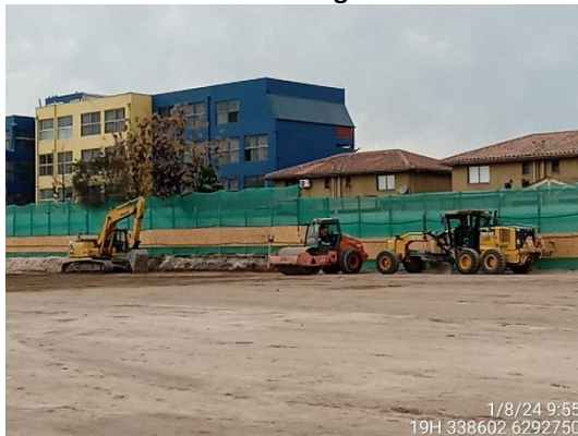
Excavadora, rodillo compactador y motoniveladora
