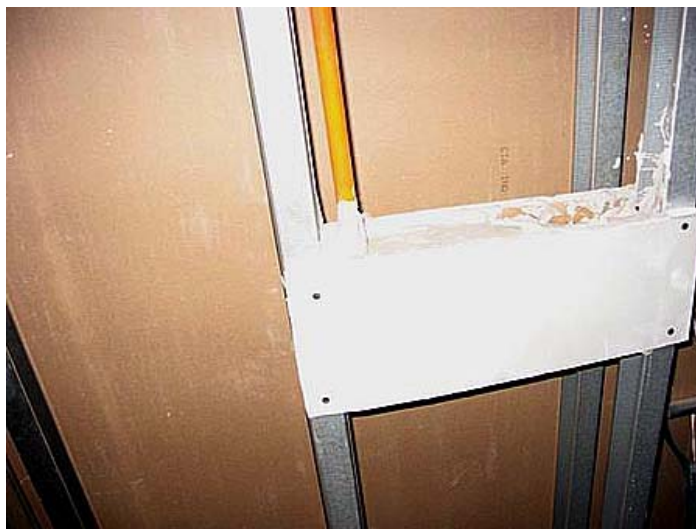
Ilustración 27. Encierro de cajas eléctricas.
