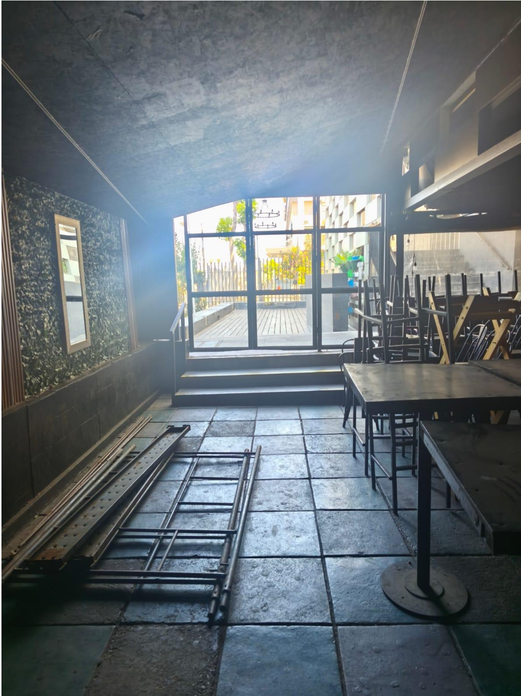
Foto 6: visión de oriente a poniente, Instalacion de puerta hacia salida
