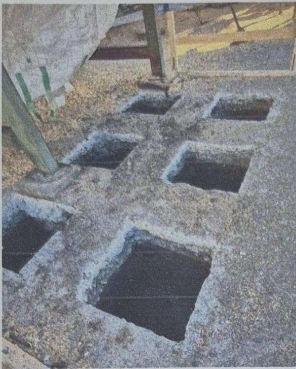
Excavaciones para cimientos triturador
