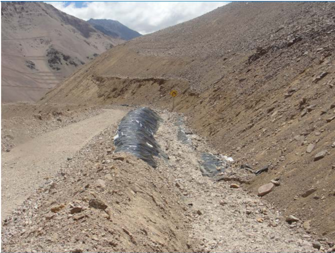
Foto 3-3: Canal auxiliar sector con lámina 12-02-2013
