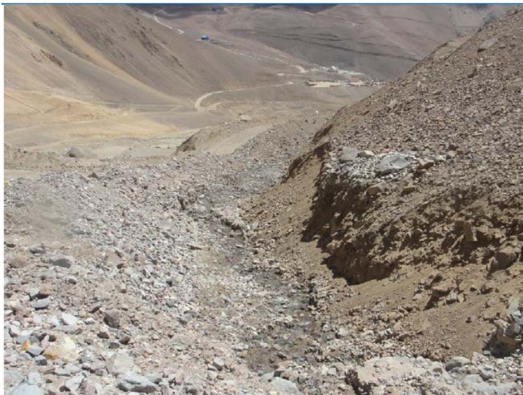
Foto 3-1: Inicio Canal Auxiliar 12-02-2013
