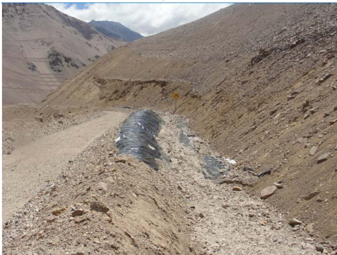
Foto 3-3: Canal auxiliar sector con lámina 12-02-2013
