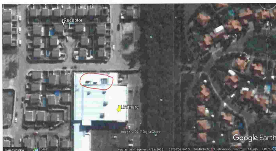
Imagen 1. Se destaca en un círculo los equipos de aire acondicionado y motores de cámaras de frío de la azotea del Supermercado Unimarc de Pedro Fontova N°7626, Huechuraba, el día 15 de abril de 2012. Fuente. Elaboración propia utilizando imágenes de Google Earth .
