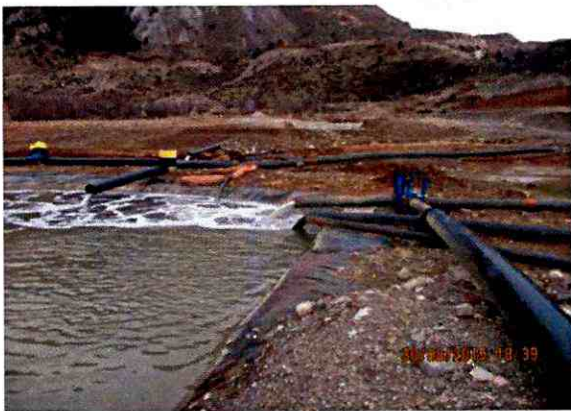
Fotografía 3, instalación válvulas By pass
