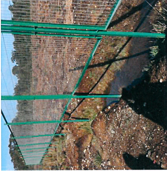
Imagen N° 8: Separación entre la base del cerco perimetral y el nivel natural del suelo, julio de 2017.
