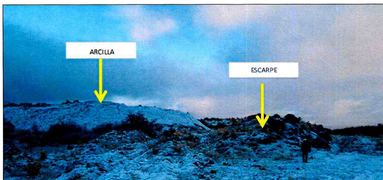
Imagen 4: Acopios independientes en taludes apartes
