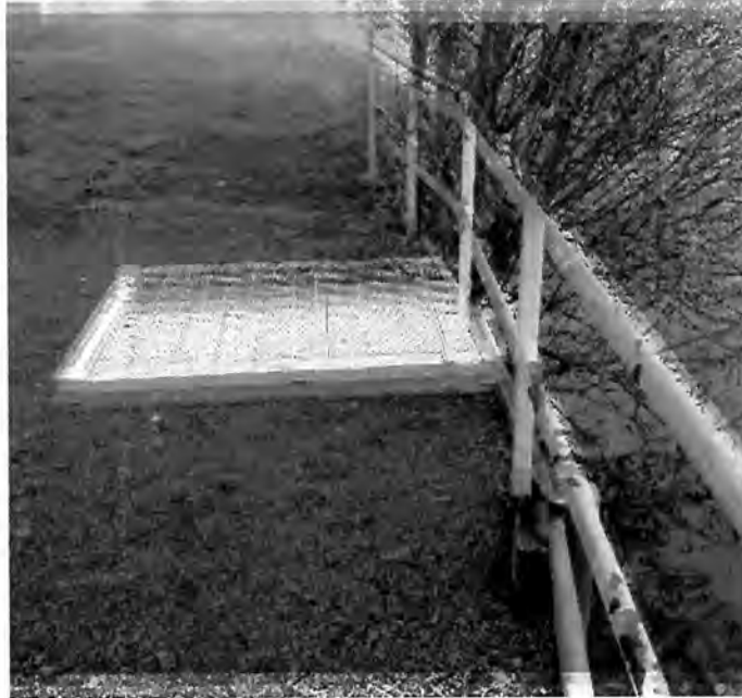
Fuente: Fotografía N° 5 Informe de fiscalización DFZ-2017-5641-XIV-SRCA-IA
