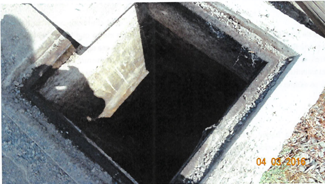
Imagen 4. Evidencia de pozo de infiltración no sellado.
