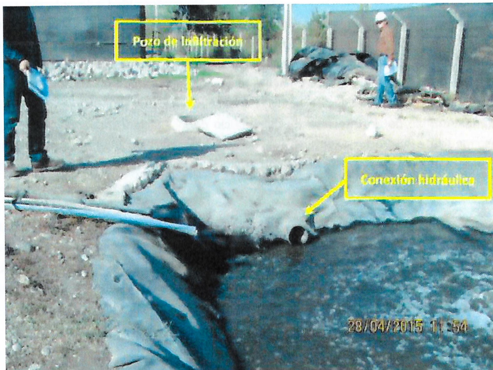
Imagen 3. Conexión hidráulica entre estanque de acumulación y pozo de infiltración de efluente
