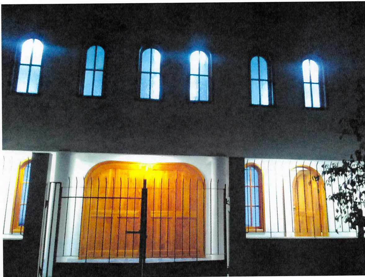
Fotografía 2. Fachada de Templo "Un Remanente Fiel" posterior a a la implementación de medidas
