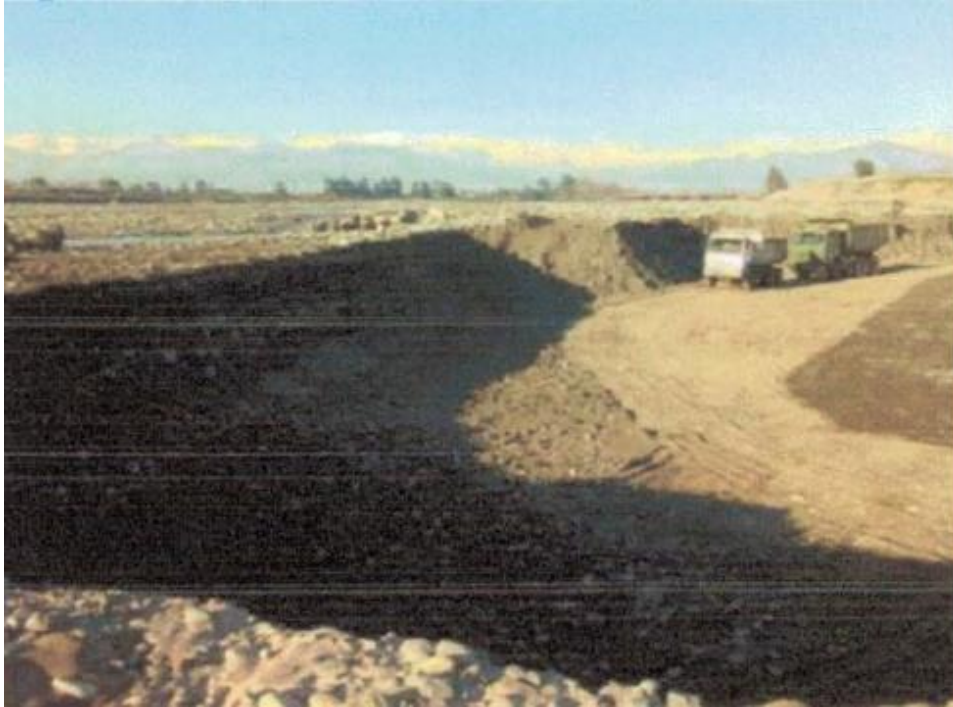
Imagen N°5. Faena de extracción de áridos constatada el día 10 de junio de 2016. Profundidad de extracción de 3,5 metros. 4
