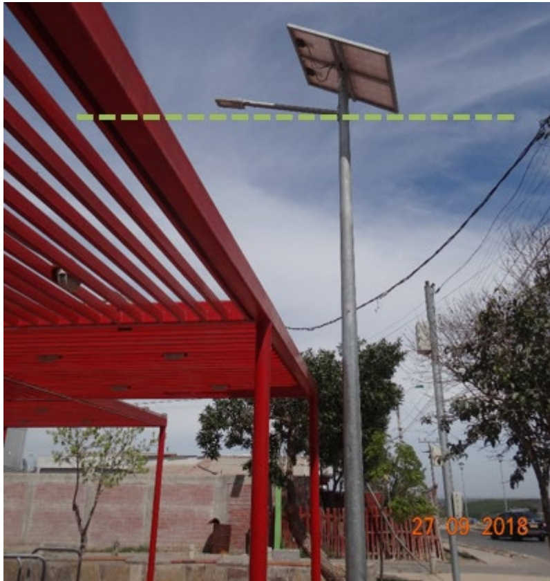
Imagen 4. Luminaria con panel fotovoltaico en Plaza González Sierra.
