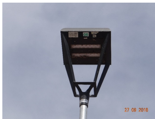
Imagen 1. Luminaria ELEC modelo ORNAMENTAL 686 LED de 60W de potencia.
