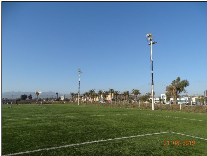
Imagen 1. Vista general del sistema de alumbrado deportivo de las Canchas Toronto Eagles.
