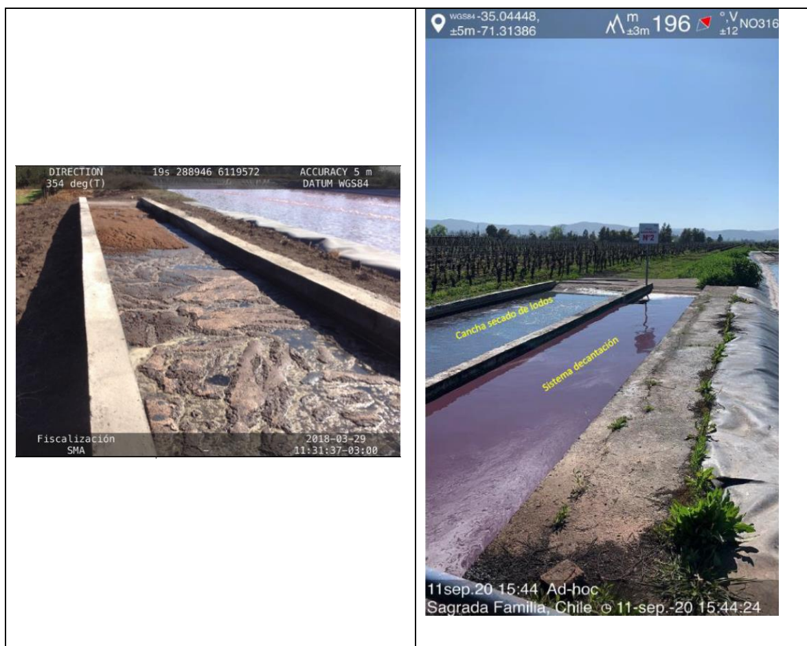
Figura 1. Comparación entre fotografías del sistema de decantación de lodos de Viña Astaburuaga, para los días 29 de marzo de 2018 y 11 de septiembre de 2020
