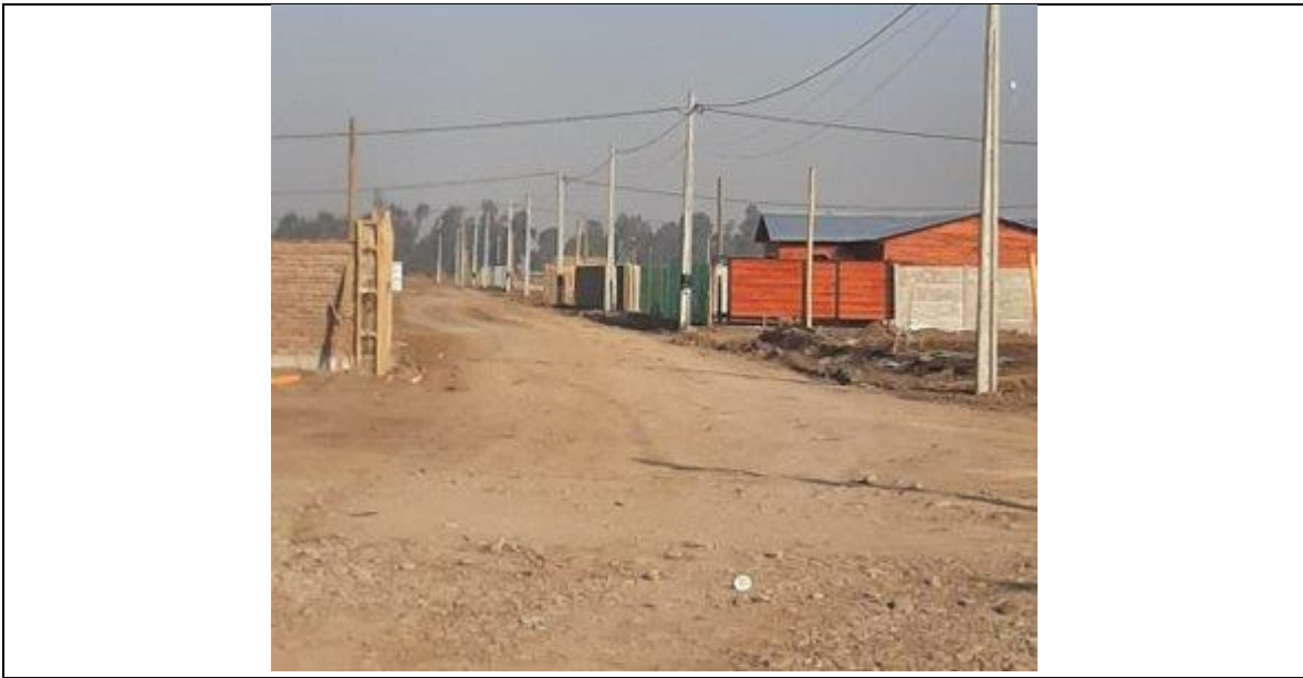
Imagen N° 10. Suministro de energía eléctrica
