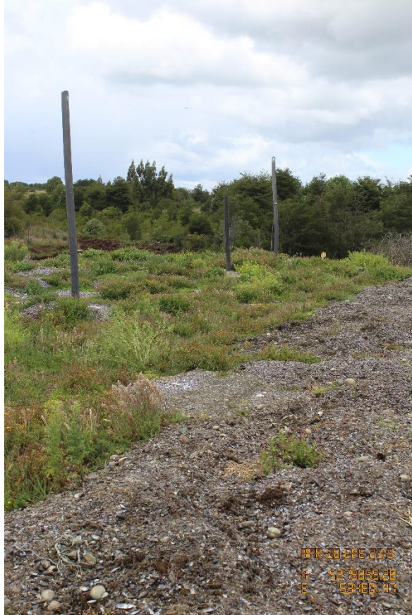
Imagen N° 25: Celda N° 32 que evidencia cobertura final parcial
