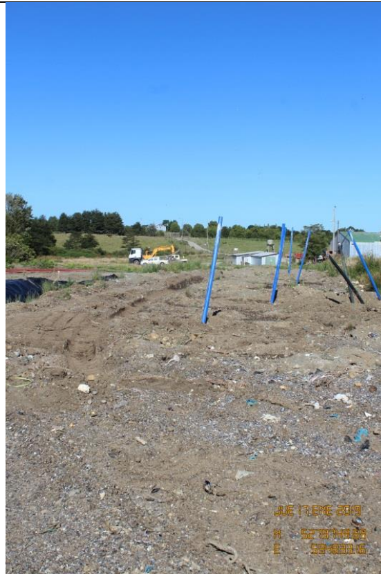
Imagen N° 19: Celda N° 23 que evidencia falta de cobertura final
