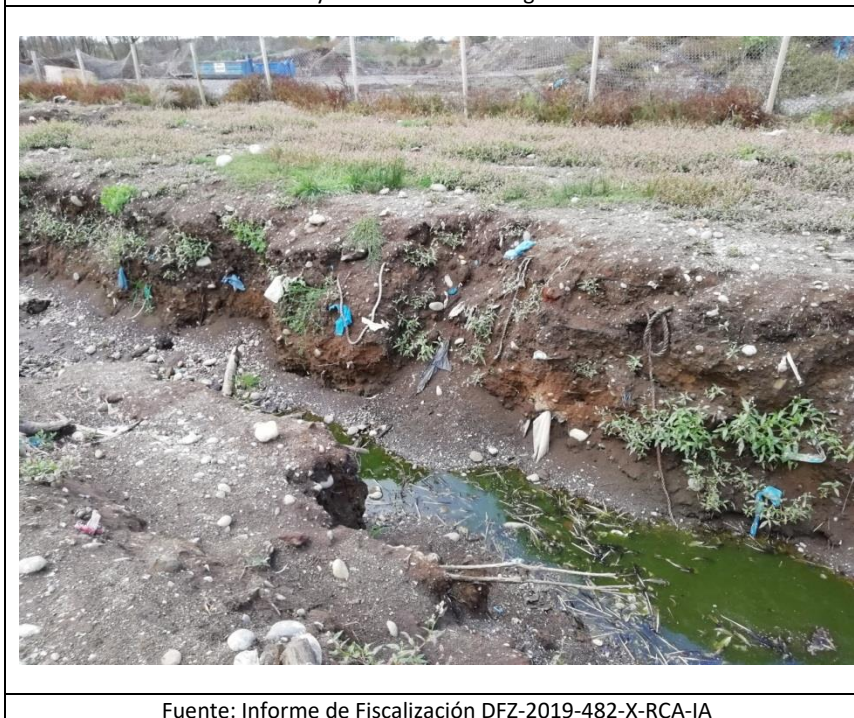
Imagen N° 34: Canal perimetral sector oeste, donde se observa residuos en su pared y estancamiento de agua
