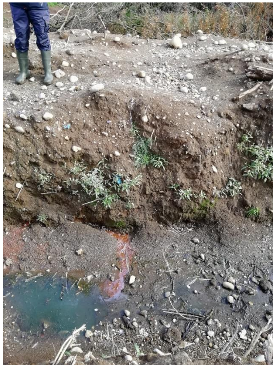
Imagen N° 40: Canal perimetral sector oeste, donde se observa afloramiento de líquidos lixiviados
