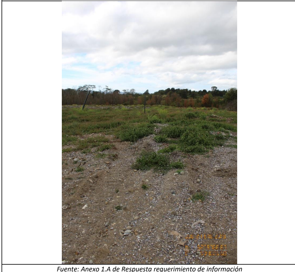
Imagen N° 23: Celda N° 30 que evidencia cobertura final parcial
