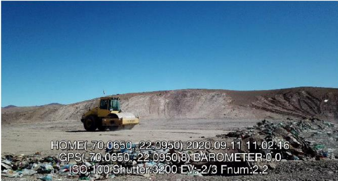
Imagen N° 3 – Residuos no compactados ni cubiertos.
