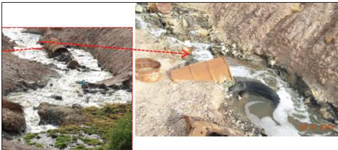
Imagen N° 6 – Caudal espumoso en sector de quebrada Mina de Cal en cruce con Ruta C-13
