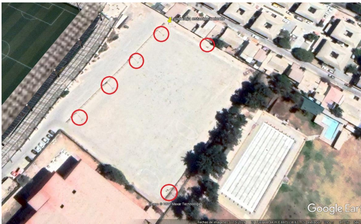
Imagen 7. Luminarias Estadio LVH, sector Estacionamiento.
