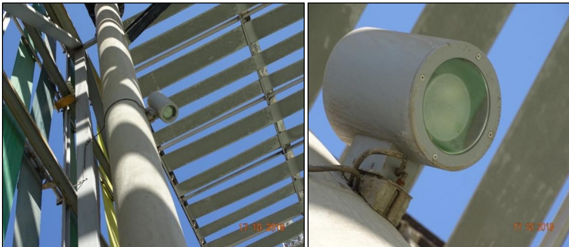
Imagen 2. Vista general y acercamiento luminarias en sector pilares (Luminaria N° 3).
