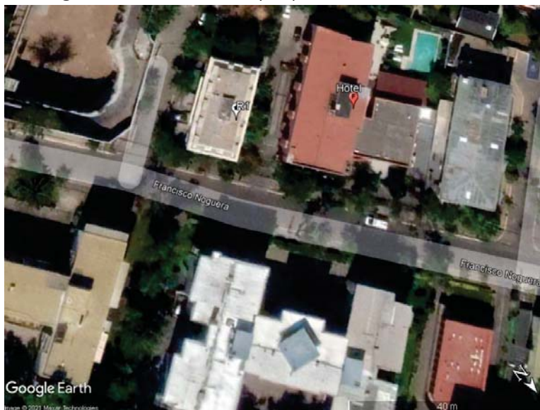
Imagen N°1. Servitur Hoteles y disposición de aire acondicionado
