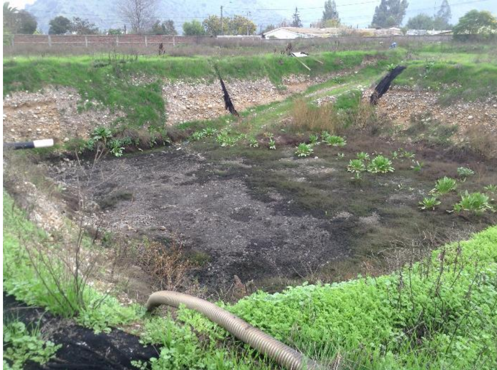
Imagen 1. Vista pozo de infiltración.
