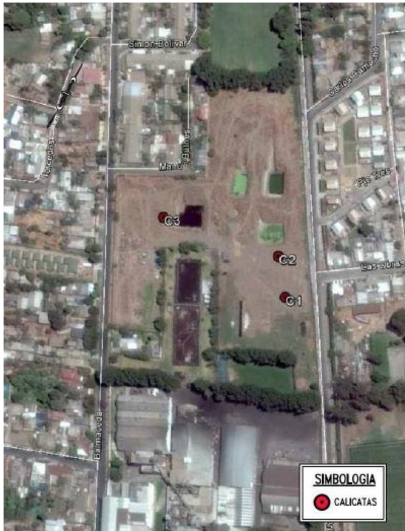
Imagen 3. Vista aérea pozos de infiltración.
