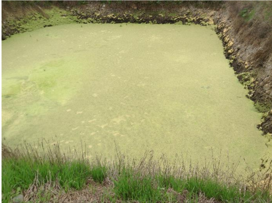
Imagen 2. Vista pozo de infiltración en uso.
