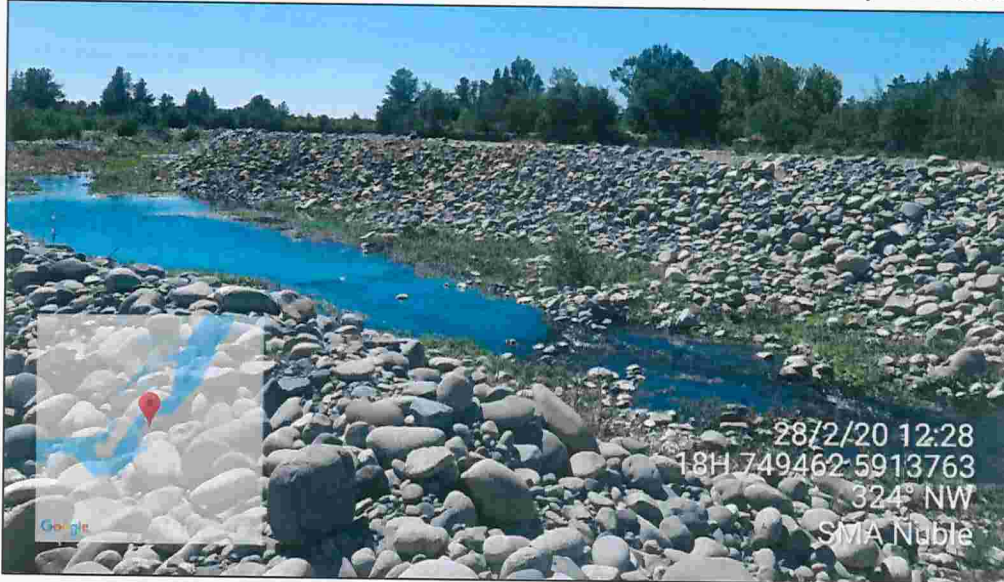
Imagen 2: Pretil de contención dentro del cauce y desviación de 1,5 m de altura y 200 m de largo
