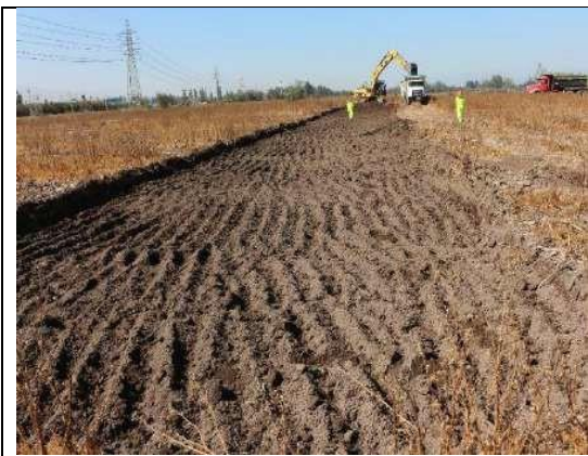
Figura 17. Inicio excavación primera nave (26 de febrero de 2018).
