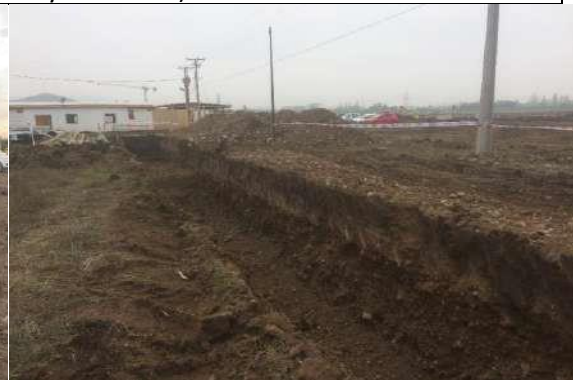
Figura 42. Excavación dren, Sector 1 y 2 (2 de mayo de 2018).
